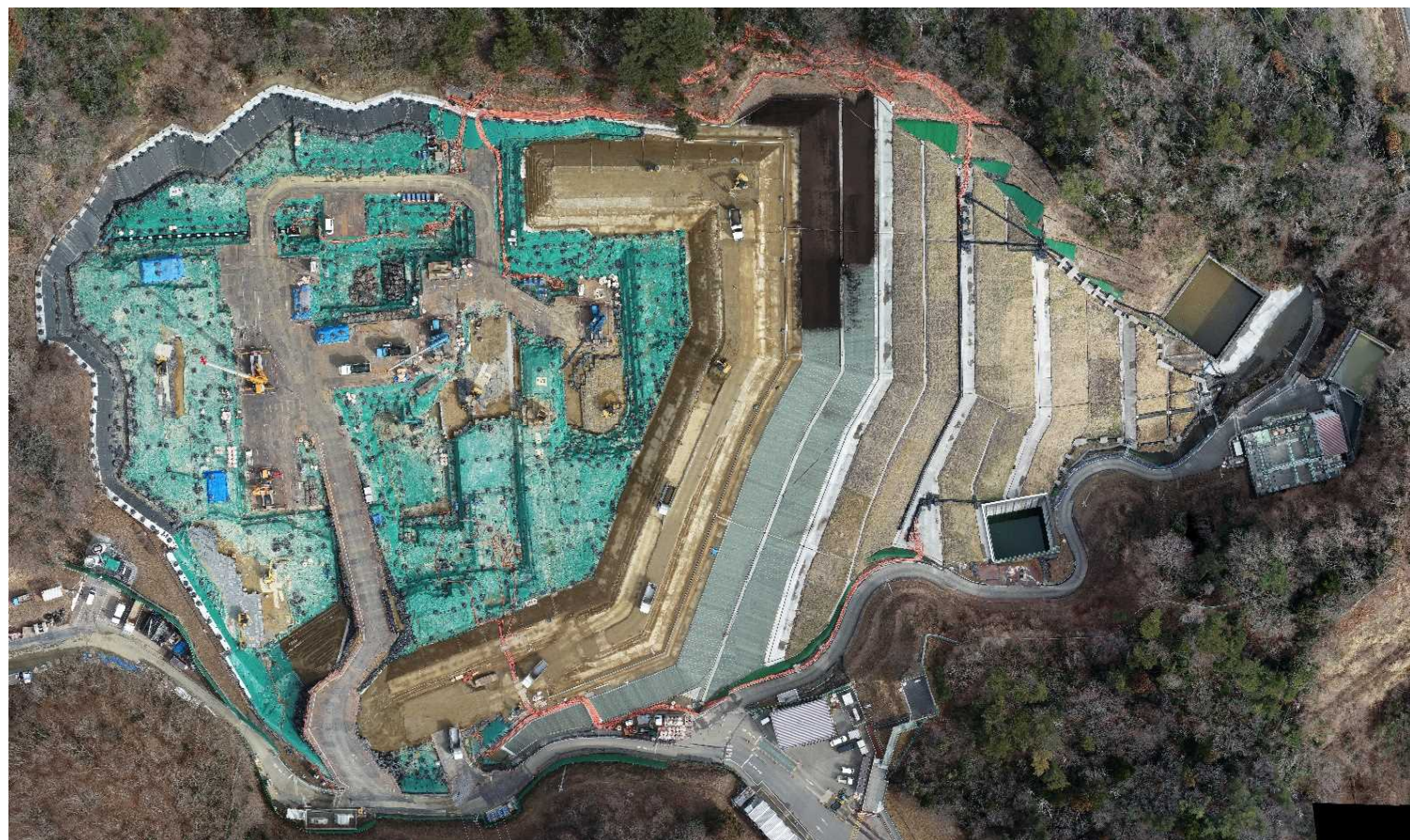
特定廃棄物埋立処分施設 （2023年2月15日撮影）
