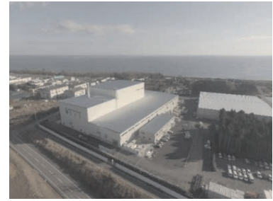
大熊町の仮設焼却施設
