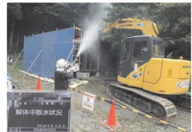
被災家屋等の解体の様子
