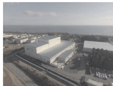
大熊町の仮設焼却施設
