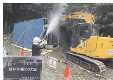
被災家屋等の解体の様子
