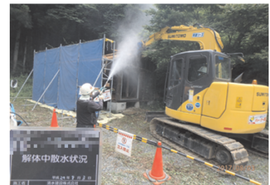
被災家屋等の解体の様子
