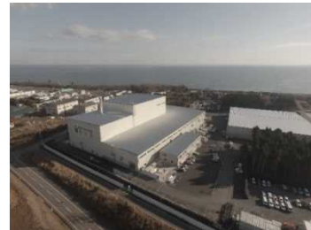
大熊町の仮設焼却施設
