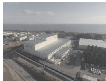
大熊町の仮設焼却施設
