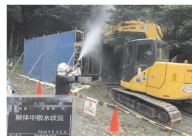
被災家屋等の解体の様子
