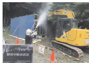
被災家屋等の解体の様子
