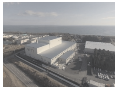
大熊町の仮設焼却施設
