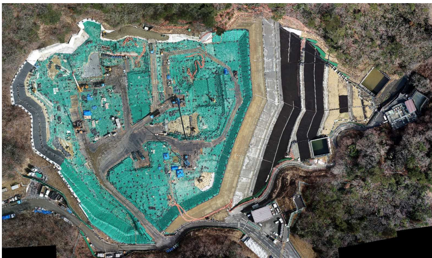
特定廃棄物埋立処分施設 （2022年3月15日撮影）
