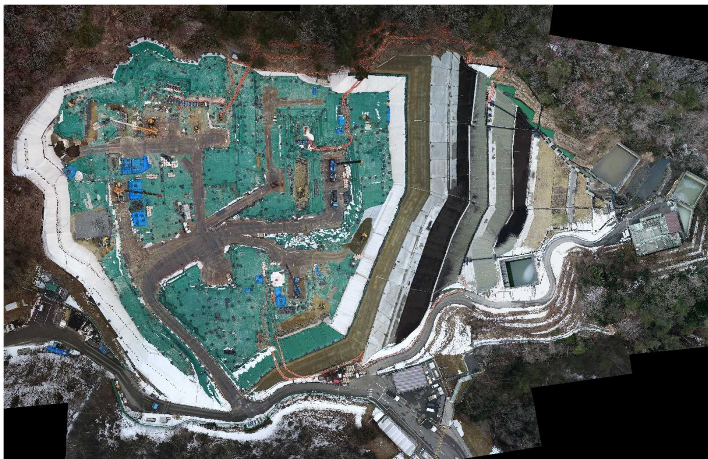
特定廃棄物埋立処分施設 （2022年2月15日撮影）
