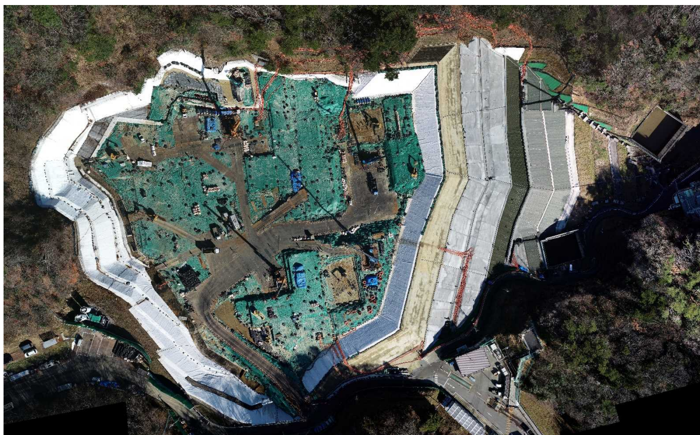
特定廃棄物埋立処分施設 （2021年12月15日撮影）
