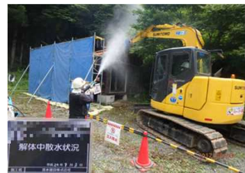
被災家屋等の解体の様子
