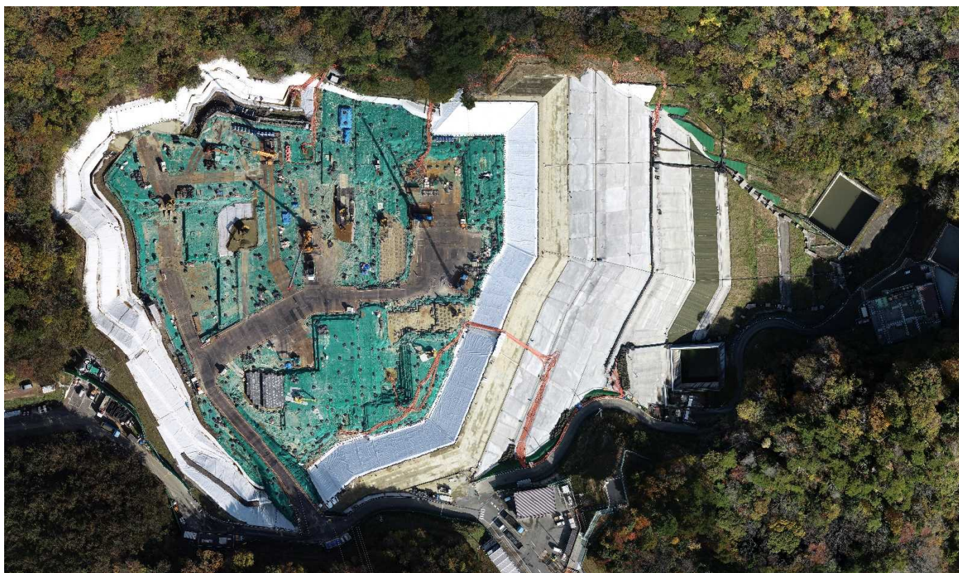
特定廃棄物埋立処分施設 （2021年11月15日撮影）
