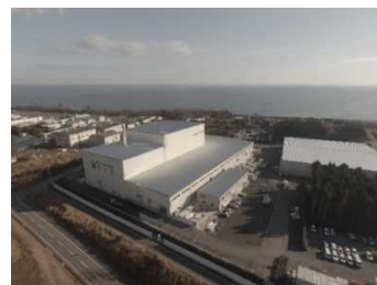
大熊町の仮設焼却施設
