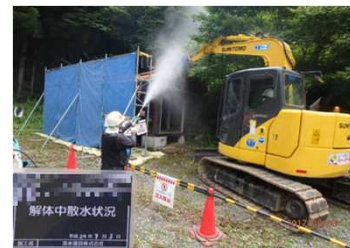
被災家屋等の解体の様子
