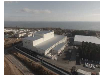
大熊町の仮設焼却施設
