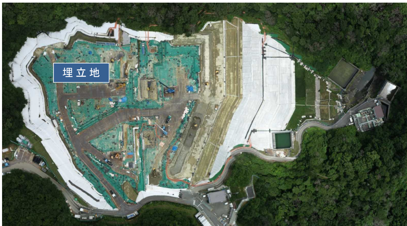
特定廃棄物埋立処分施設（2021年7月15日撮影）
