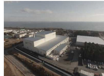
大熊町の仮設焼却施設
