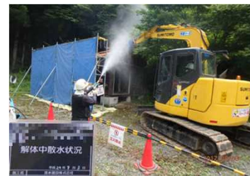
被災家屋等の解体の様子
