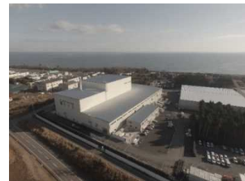
大熊町の仮設焼却施設
