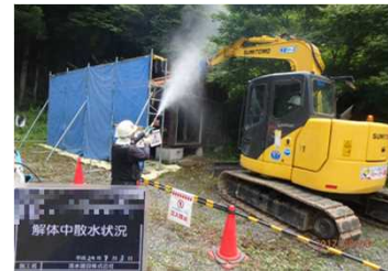
被災家屋等の解体の様子
