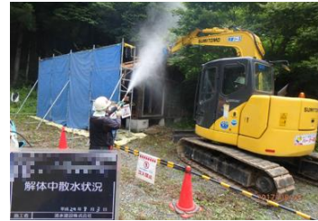
被災家屋等の解体の様子
