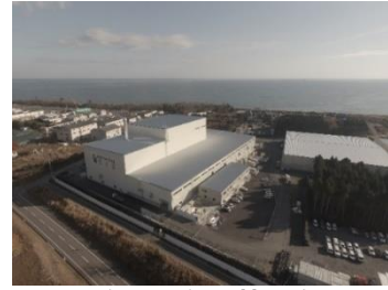
大熊町の仮設焼却施設
