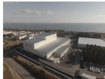
大熊町の仮設焼却施設
