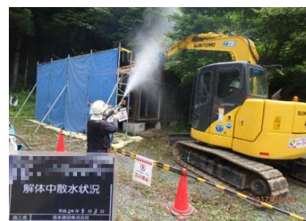
被災家屋等の解体の様子
