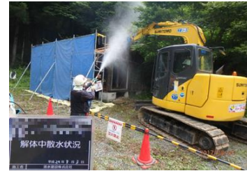
被災家屋等の解体の様子
