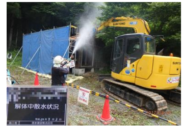
被災家屋等の解体の様子
