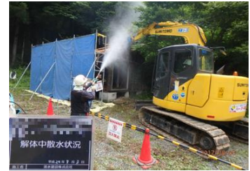
被災家屋等の解体の様子
