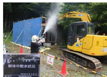
被災家屋等の解体の様子
