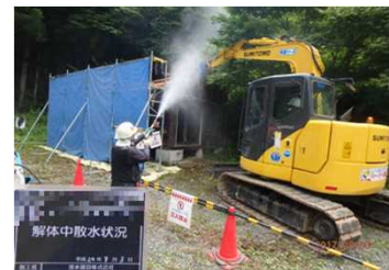
被災家屋等の解体の様子
