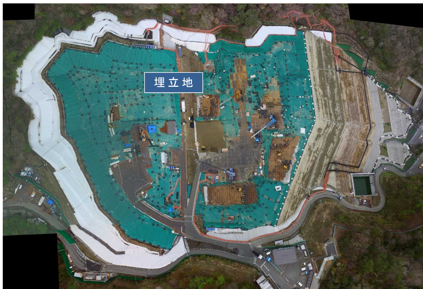
特定廃棄物埋立処分施設 （2020年4月16日撮影）
