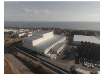
大熊町の仮設焼却施設
