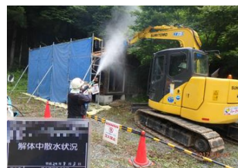
被災家屋等の解体の様子
