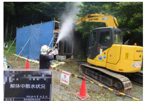
被災家屋等の解体の様子
