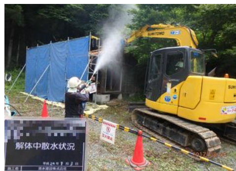
被災家屋等の解体の様子
