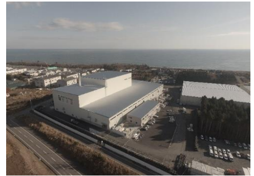
大熊町の仮設焼却施設
