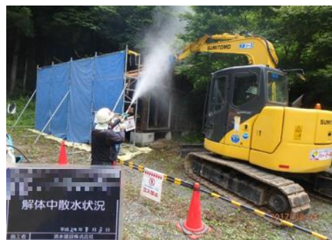
被災家屋等の解体の様子
