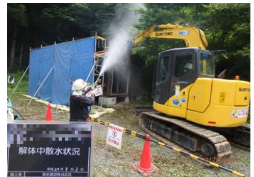
被災家屋等の解体の様子
