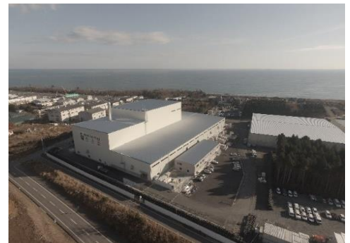
大熊町の仮設焼却施設
