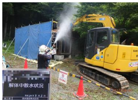
被災家屋等の解体の様子
