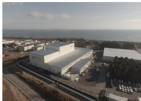
大熊町の仮設焼却施設
