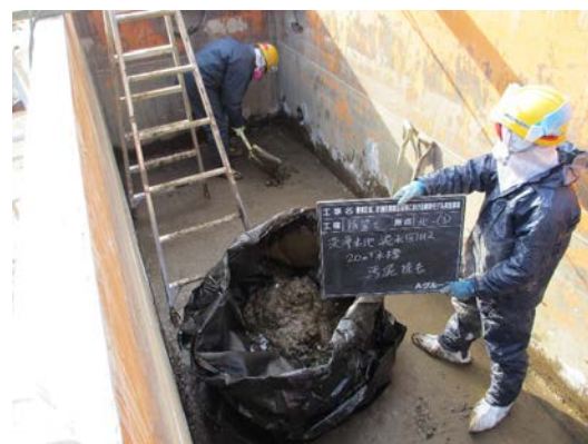
沈殿固化物の回収
