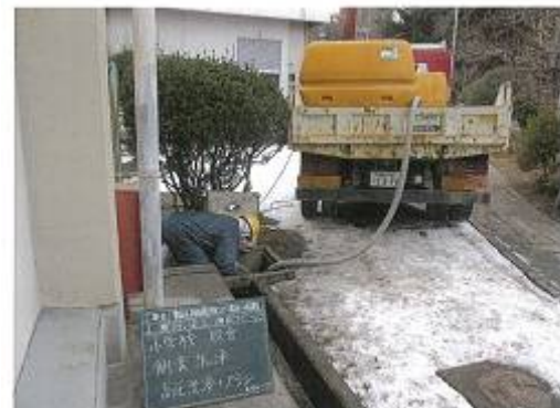
2012年1月27日小学校側溝洗浄時
