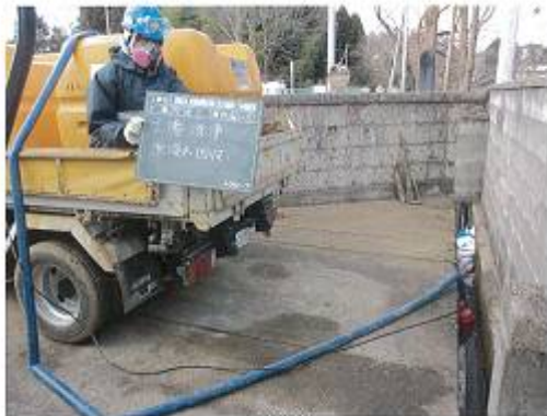
2012年1月15日工場建物洗浄時
