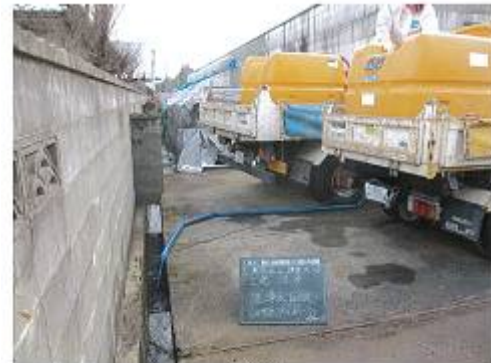
2012年1月12日工場建物洗浄時
