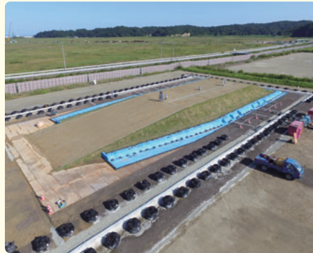
試験盛土の様子
