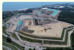
土壌貯蔵施設(大熊5工区)
