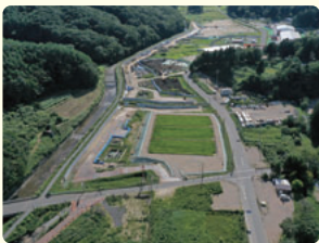
農地盛土造成エリア全景
