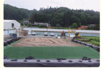
再生資材を用いた試験盛土 (2019～2021年度)
