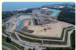
土壌貯蔵施設(大熊5工区)
