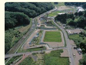
農地盛土造成エリア全景
