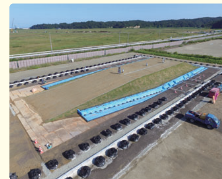
試験盛土の様子
