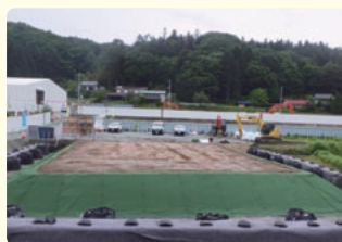
再生資材を用いた試験盛土 (2019~2021年度)
