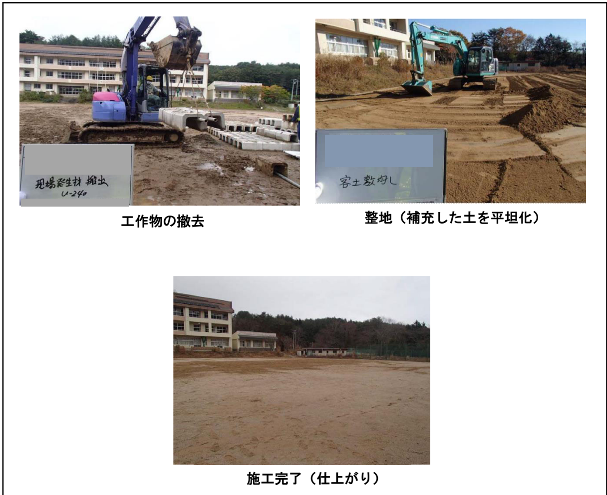
図 4-17 復旧工事の施工手順（学校のグラウンドの例）
