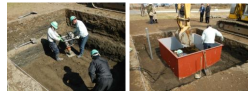
試験施工の様子
