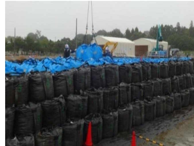
保管場への定置作業
