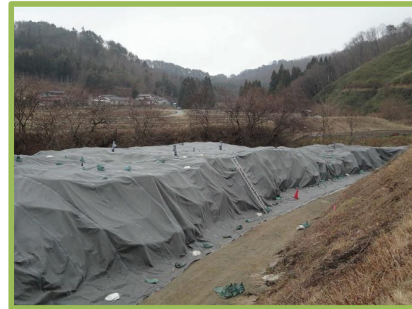
雨水浸入防止の措置の例
