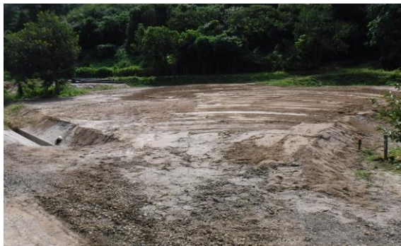
工作物・現場発生材撤去直後
