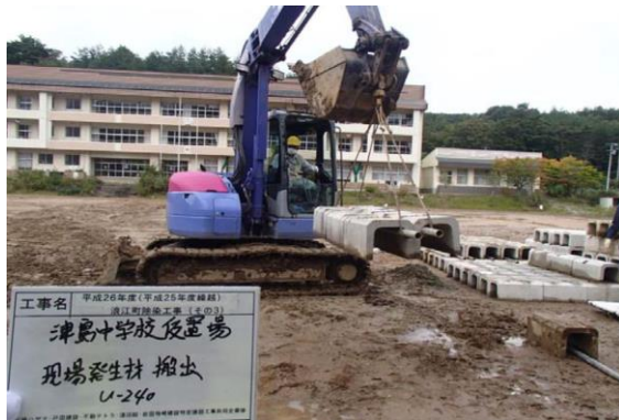
工作物・現場発生材撤去
