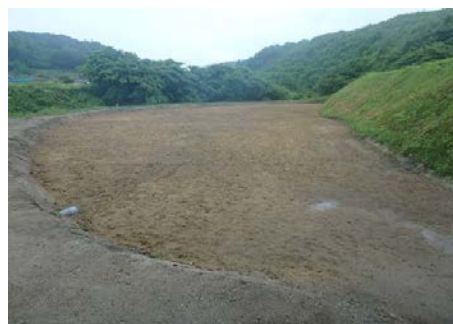
仕上がり状況(直後)
