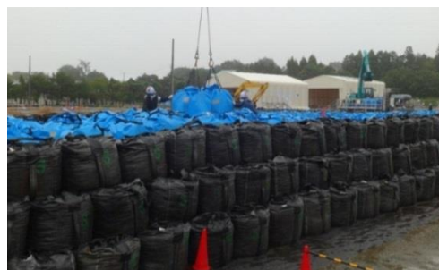
保管場への定置作業
