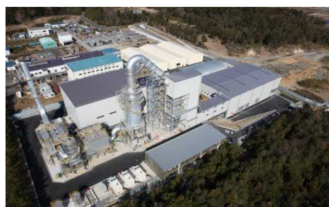
南相馬市の仮設焼却施設 (平成27年3月)
