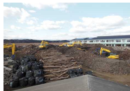
撤去前(平成26年1月)
