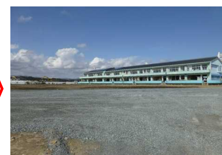
撤去後(平成27年3月)
