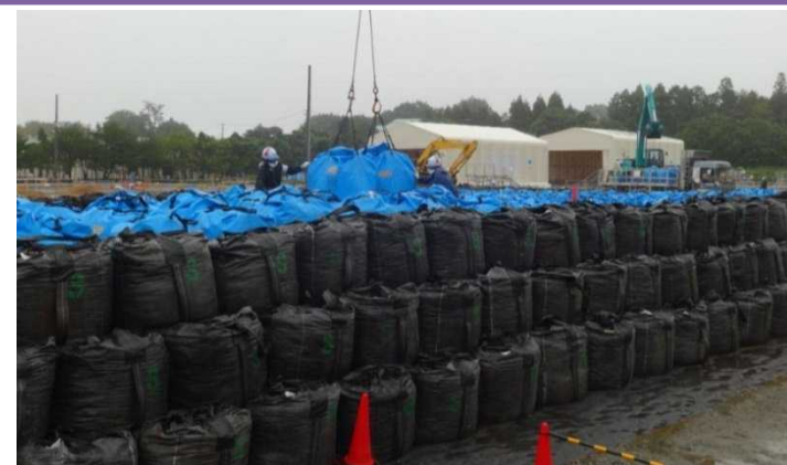
保管場への定置作業
