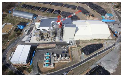
葛尾村の仮設焼却施設 (平成27年4月)
