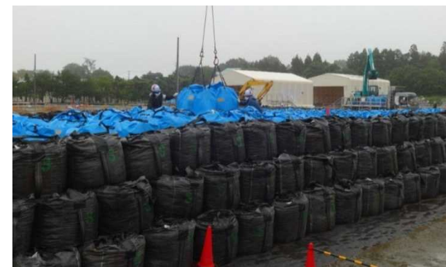
保管場への定置作業
