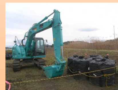
土のう袋の固定
