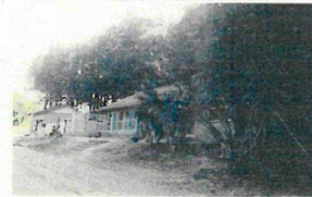
写真1: 除染対象地の状況
