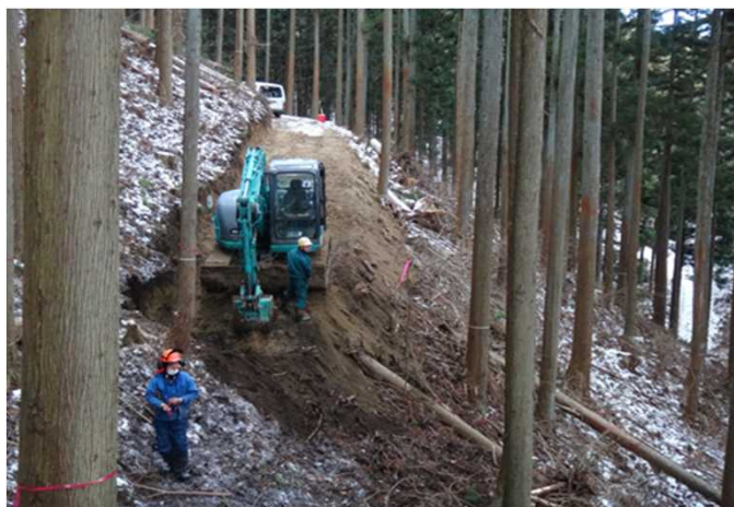
作業道の整備状況
