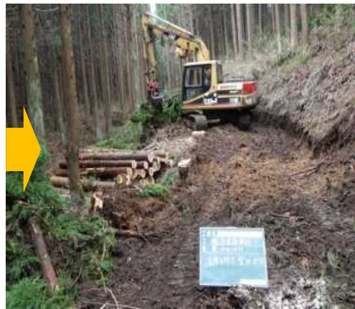
②作業道整備
