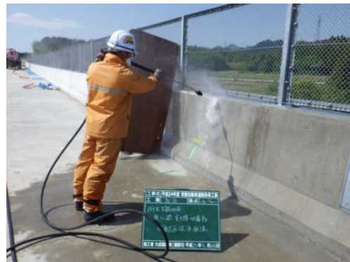
橋梁の洗浄作業
