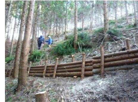
放射性物質を含む枝葉や土壌が森林外に流出しないよう、間伐木の枝葉を林内で集積(写真左)するとともに、木柵工を設置(写真右)
